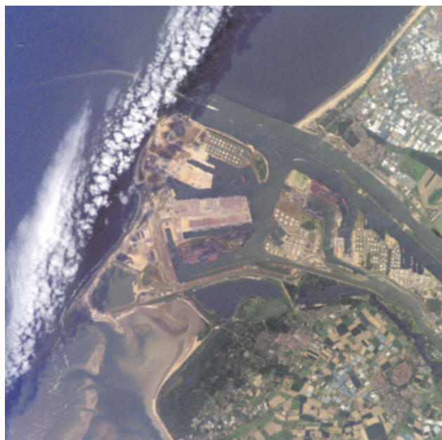
Luchtfoto Rotterdamse haven. (wikipedia.nl)
